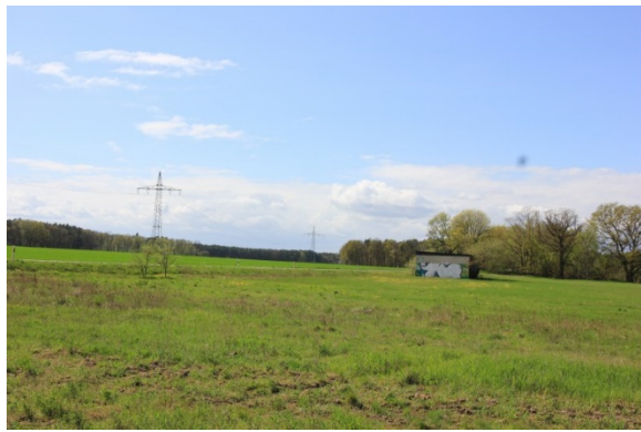
Abb. 11: Trafostation östlich der Grundstückszufahrt
